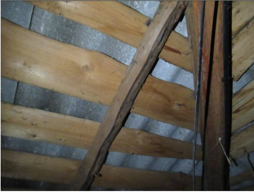
Фото 16. Вид установленной стропильной ноги в покрытии здания из горбыля.
