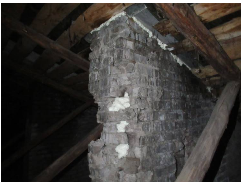
Фото 12. Вид выполненной герметизации примыкания кровли к вент. каналу монтажной пеной.
