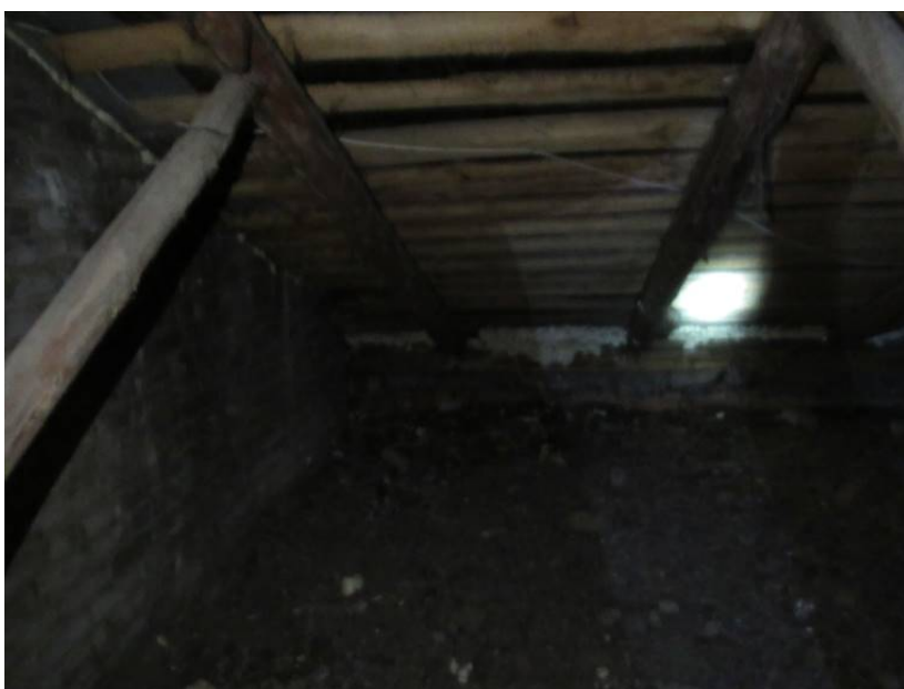
Фото 14. Вид выполненной монтажной пеной герметизации вент. зазора над мауэрлатом. Вентиляция чердачного помещения нарушена.
