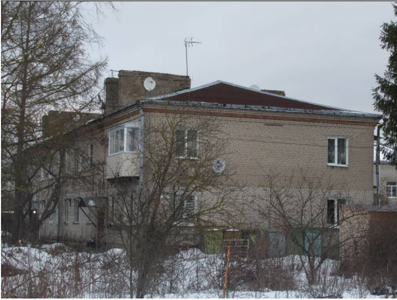
Фото 1. Общий вид здания, в котором производилось обследование конструкций покрытия и кровли (крыши здания).
